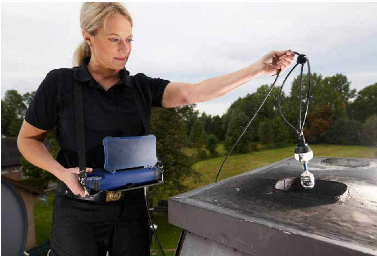
Bei der Inspektion vom Dach aus wird der Monitor sicher vor dem Körper getragen.
