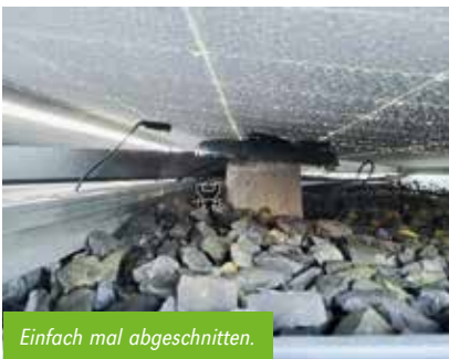
Ursprünglich mit einer schönen Abgasleitung über Dach.
